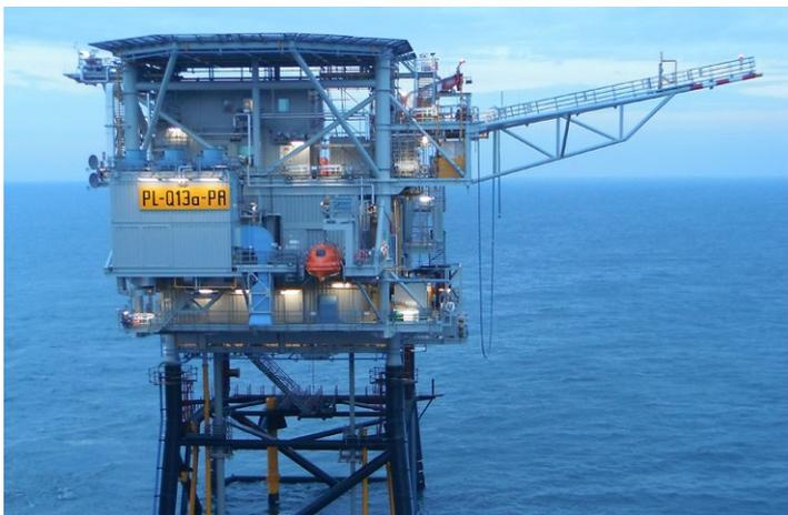
現在、オランダ沖合にある石油やガスのプラントを世界初の洋上水素プラントに転換しようという試みが行なわれています。洋上の風力タービンから生成される電力を活用して海水を脱塩水に転換し、グリーン水素を生産する1MW電解装置に動力を供給する予定です。
